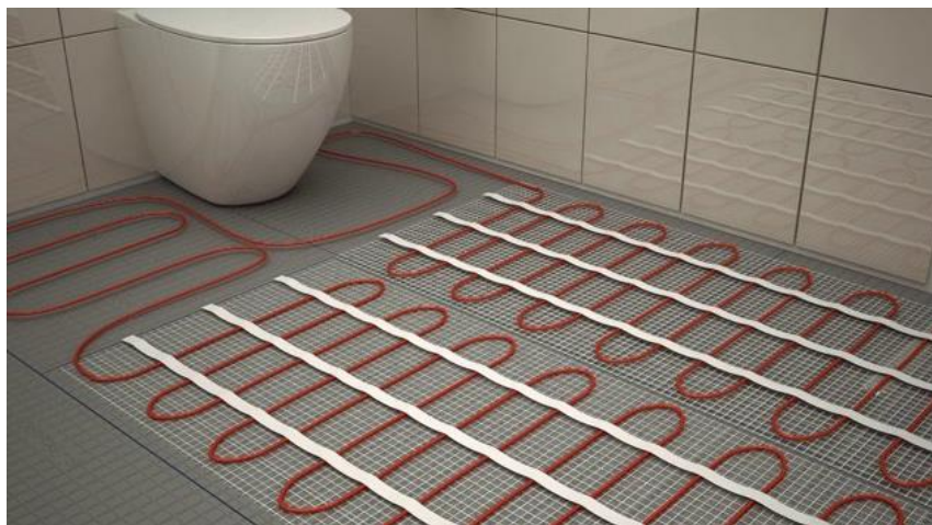
Slika 23. Serpentinasti tip polaganja petlji podnog grijanja
