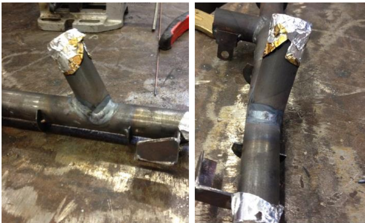
Slika 42: Zavareni spoj netom nakon zavarivanja
