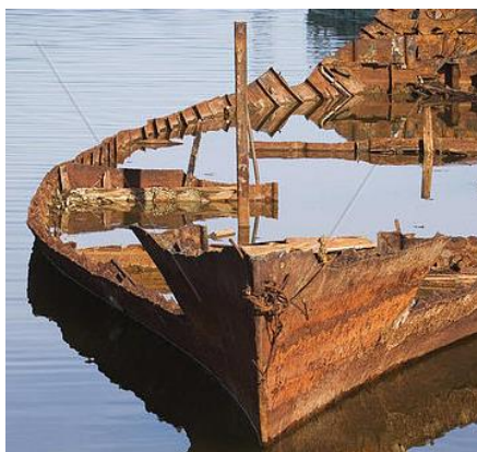
Slika 15: Plovilo uništeno korozijom.
