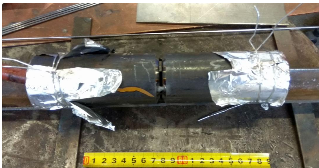
Slika 32. Izvedba zaštite korijena
