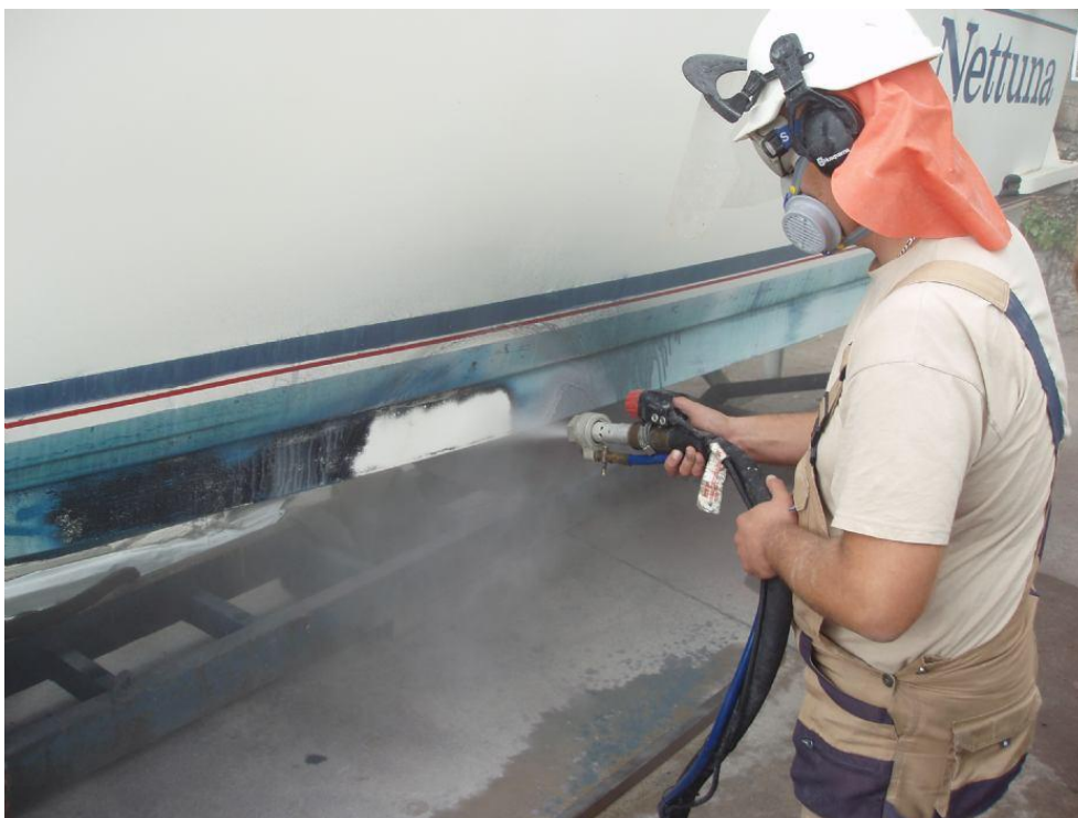
Slika 35. Čišćenje površine mlazom abraziva [38]
