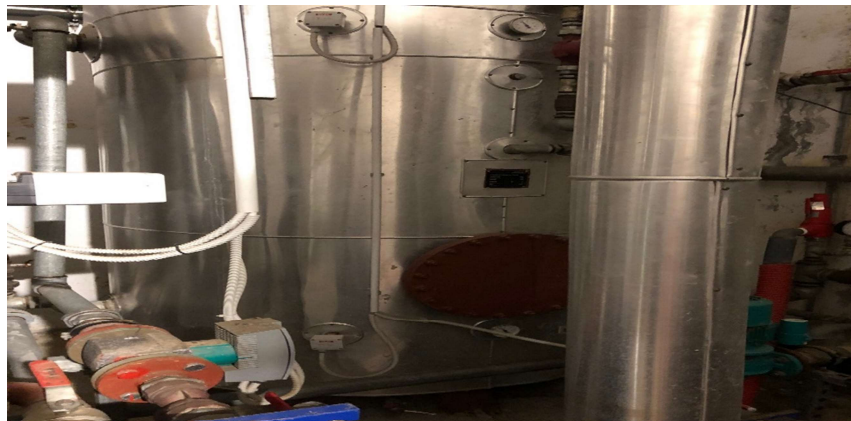
Slika 32. 2. Spremnik (bojler) za PTV
