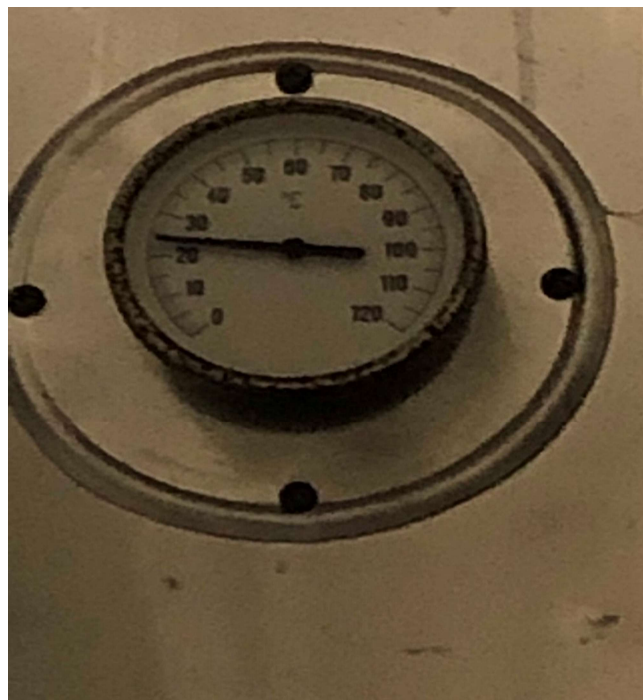
Slika 30. Temperature PTV-a u 1. spremniku (bojleru)
