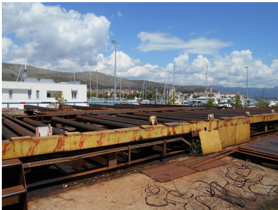
Slika 18. Profili na ulazu u sačmarilicu
