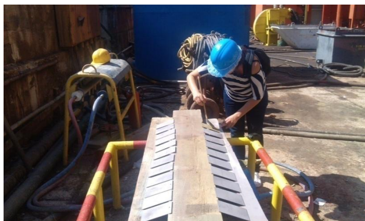
Slika 28. Nanošenje Premaza P1
