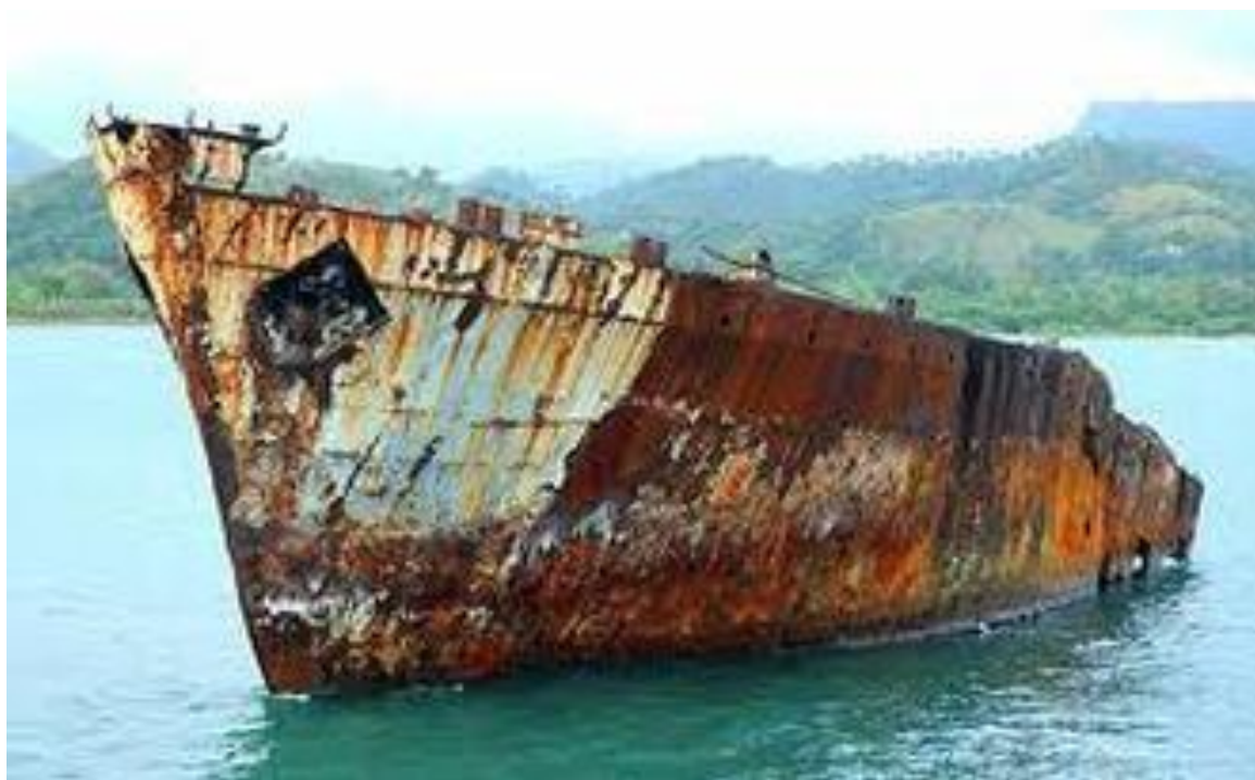
Slika 1. Brod oštećen korozijom [4]
