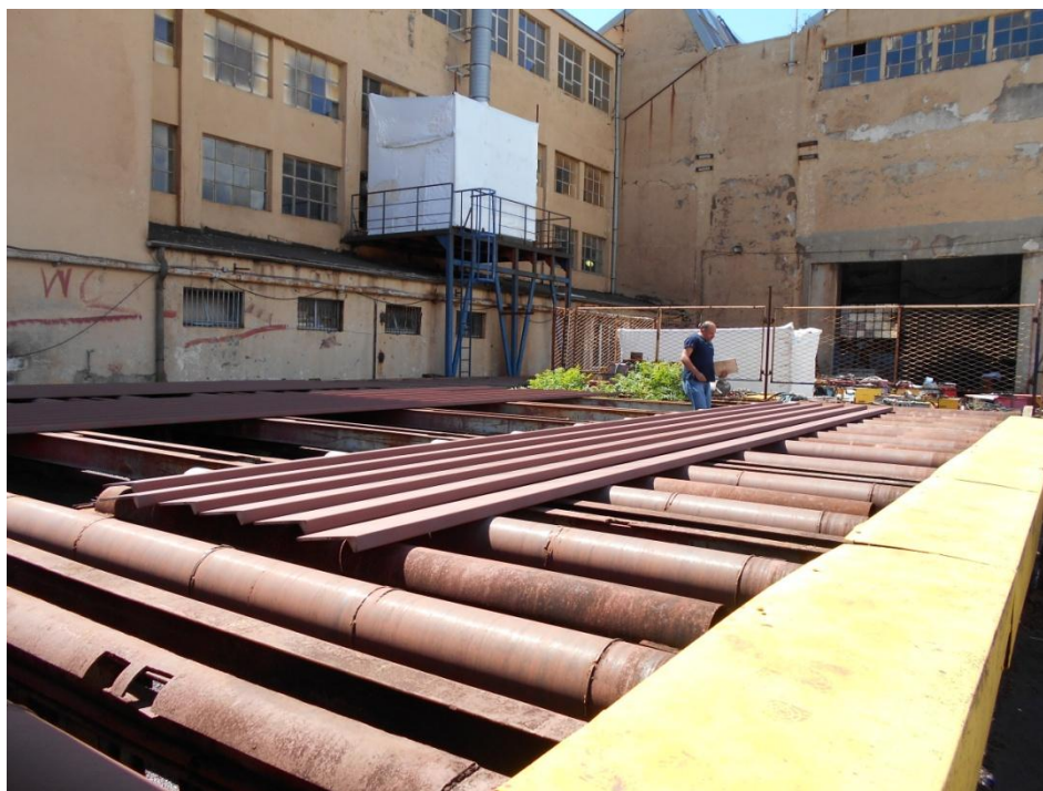
Slika 22. Profili zaštićeni temeljnim radioničkim premazom
