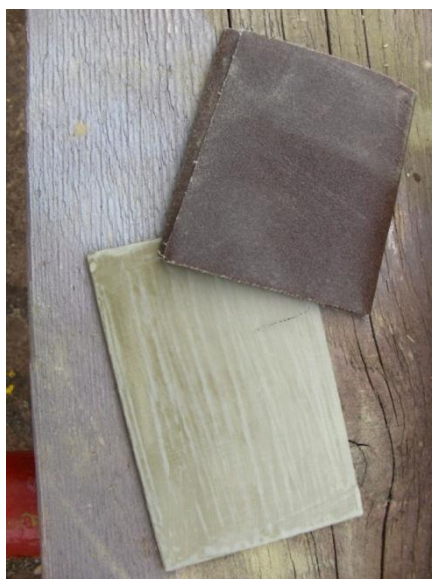
Slika 30. Aktiviranje antikoroziivnog Premaza P1 brušenjem
