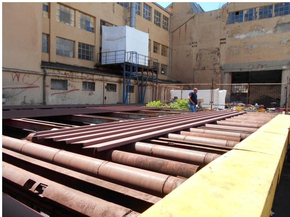
**Slika 22. Profili zaštićeni temeljnim radioničkim premazom**
