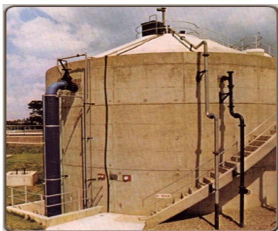
*Slika 3.21. Betonski digestor [27]*
