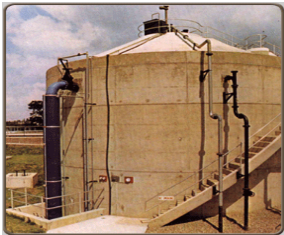
Slika 3.21. Betonski digestor [27]
