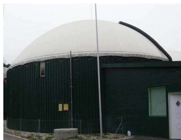
*Slika 3.22. Čelični digestor [27]*
