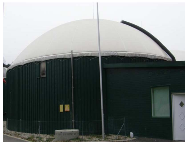
Slika 3.22. Čelični digestor [27]
