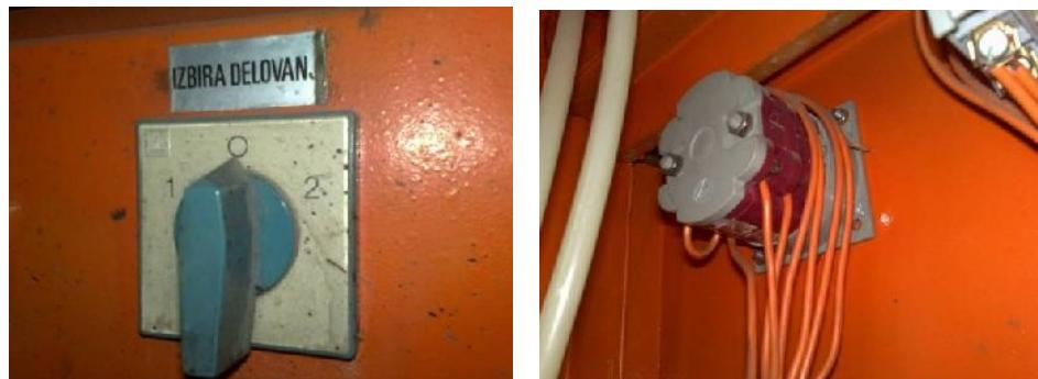
*Slika 7. Prekidač izbora načina rada motora*
