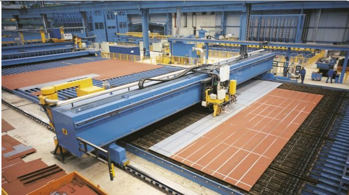
Slika 19. Zavarivanje limova palube, [10]
