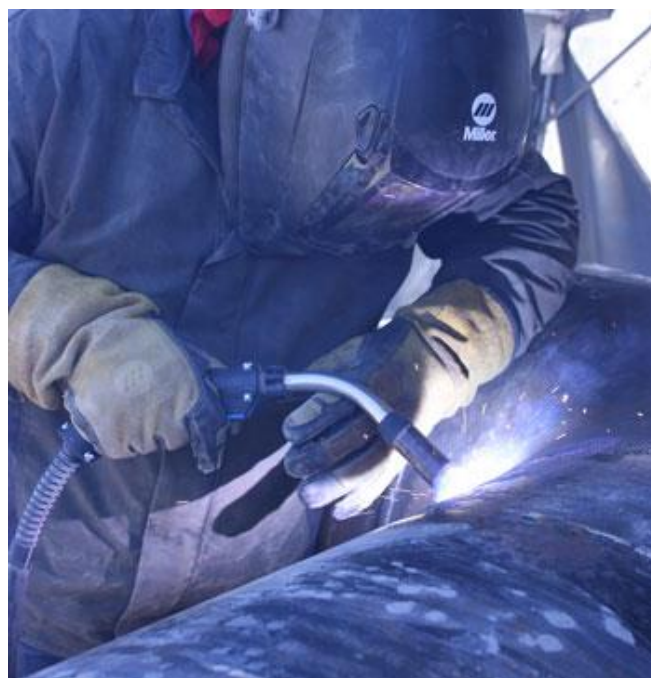
Slika 30. Ručno MAG zavarivanje čeličnih cijevi [8]
