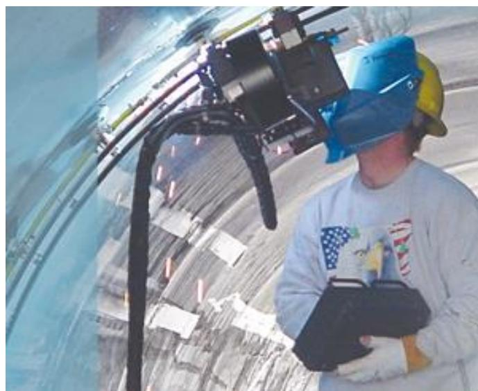
Slika 31. Poluautomatsko FCAW zavarivanje čeličnih cijevi [8]
