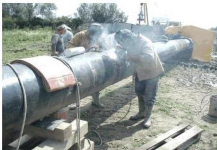
Slika 29. REL zavarivanje čeličnih cijevi celuloznom elektrodom [19]
