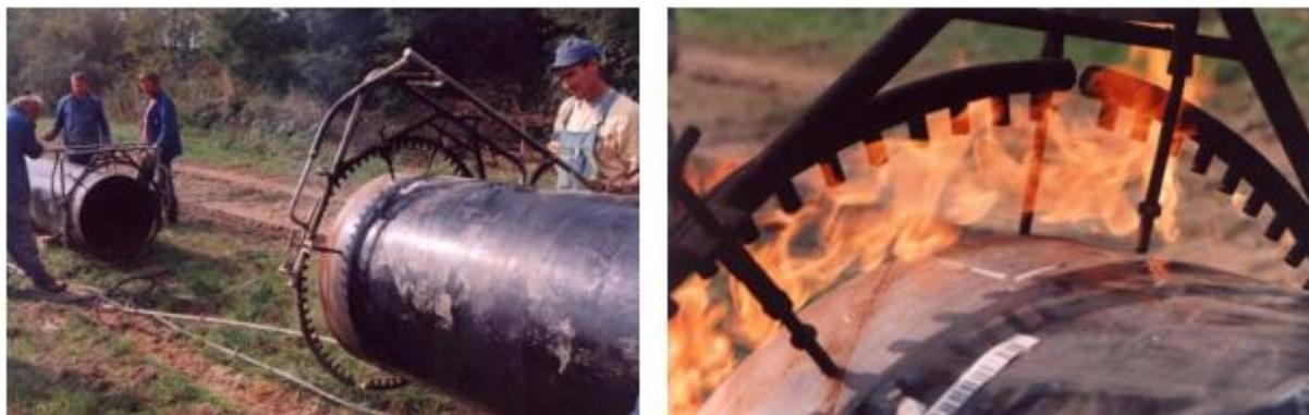
**Slika 28. Predgrijavanje čeličnih cijevi prije zavarivanja [18]**
