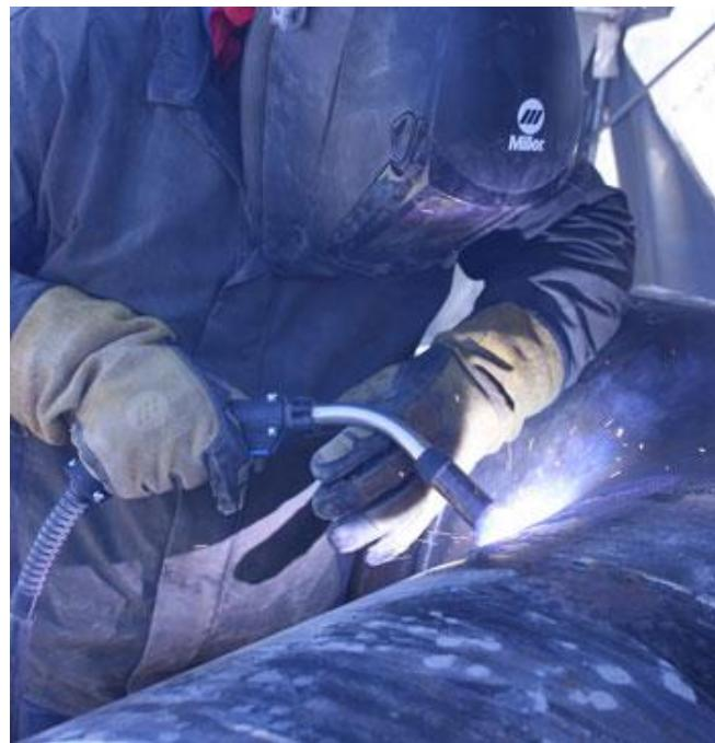
Slika 30. Ručno MAG zavarivanje čeličnih cijevi [8]
