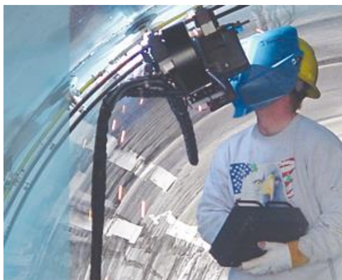
Slika 31. Poluautomatsko FCAW zavarivanje čeličnih cijevi [8]
