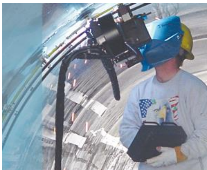
Slika 31. Poluautomatsko FCAW zavarivanje čeličnih cijevi [8]
