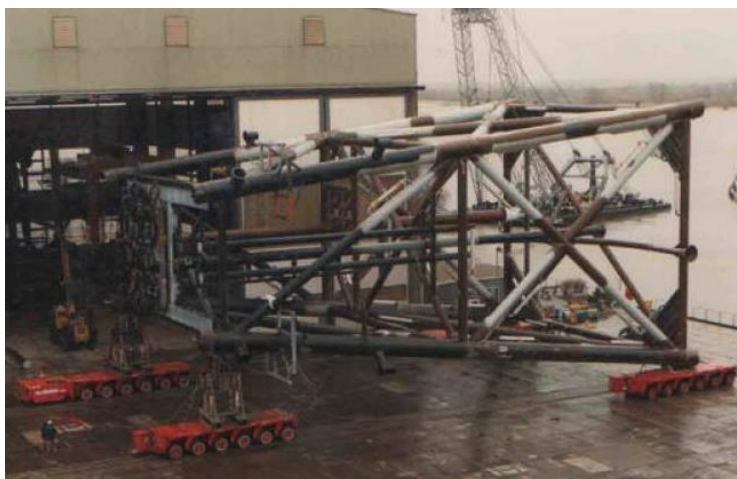
Slika 40. Prijenos pučinskog objekta parternim transporterima [24]
