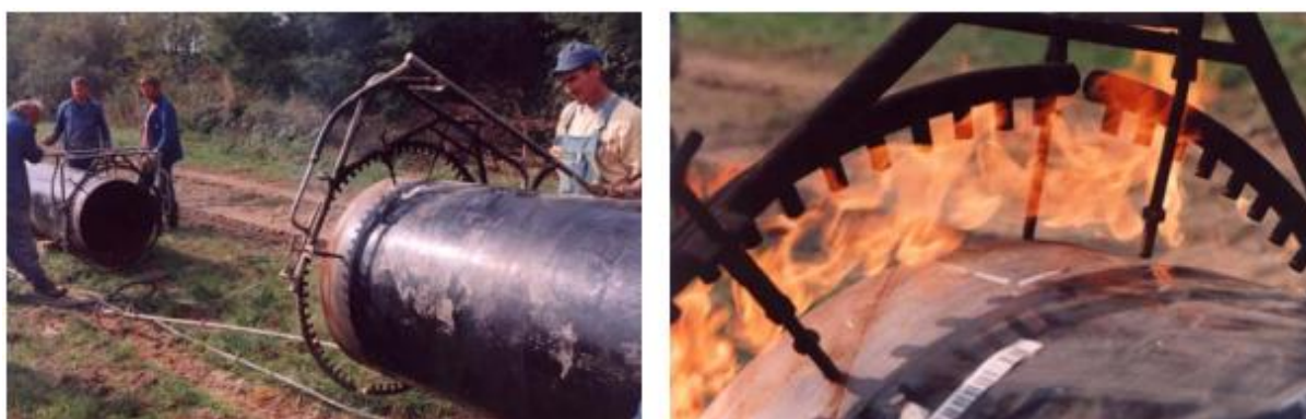
Slika 28. Predgrijavanje čeličnih cijevi prije zavarivanja [18]
