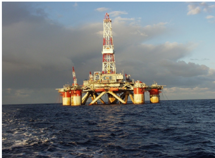
Slika 2. Pluuronjiva platforma pentagonalnog tipa
