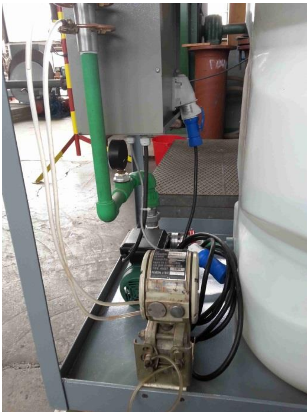
Slika 8. Stvarna izvedba mjernog lanca za mjerenje protoka
