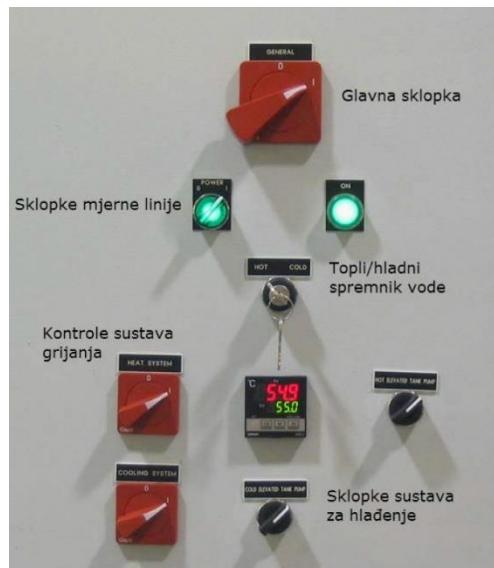
**Slika 26. Prikaz prekidača na elektro-ormariću ispitne linije**
