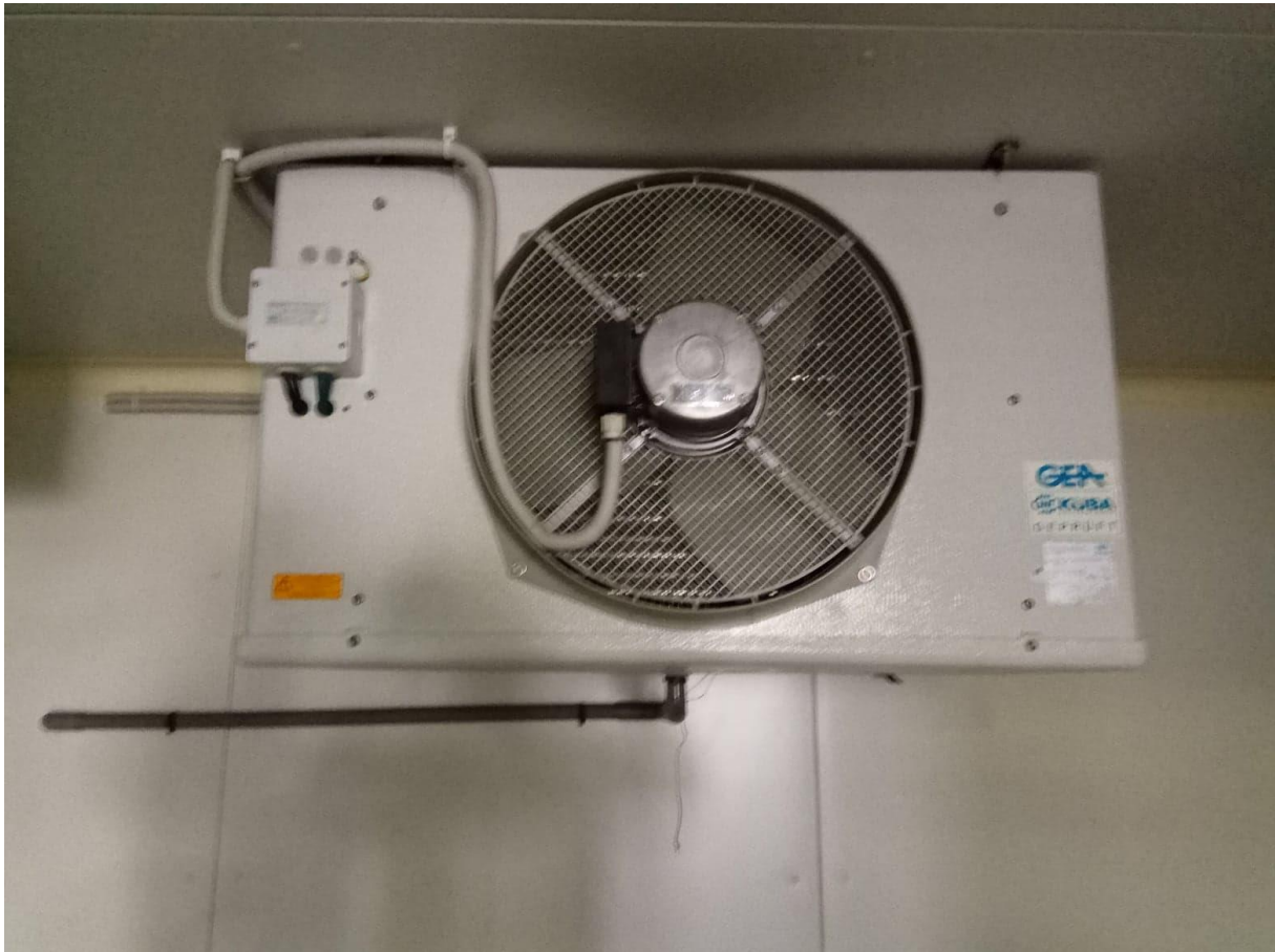
Slika 3. Isparivač GEA Küba SGLE 091C
