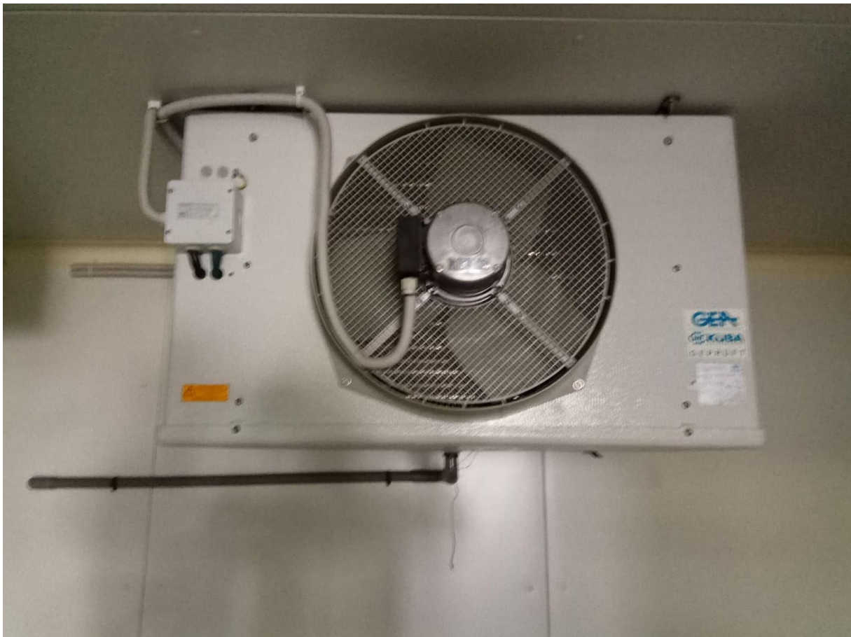
Slika 3. Isparivač GEA Küba SGLE 091C
