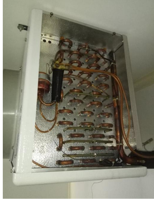
Slika 4. Termoekspanzijski ventil isparivača
