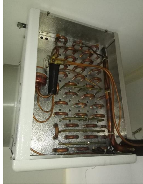
Slika 4. Termoekspanzijski ventil isparivača
