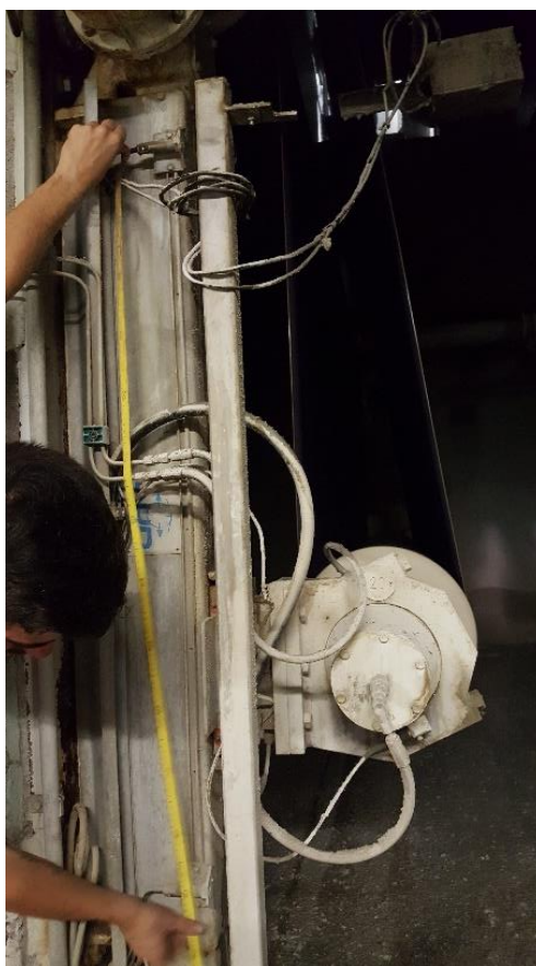
Slika 37. Pozicioniranje za mjerenje preostalog/iskorištenog hoda napinjača
