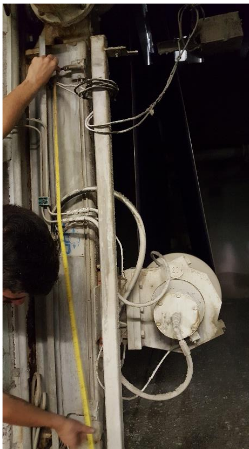
Slika 37. Pozicioniranje za mjerenje preostalog/iskorištenog hoda napinjača
