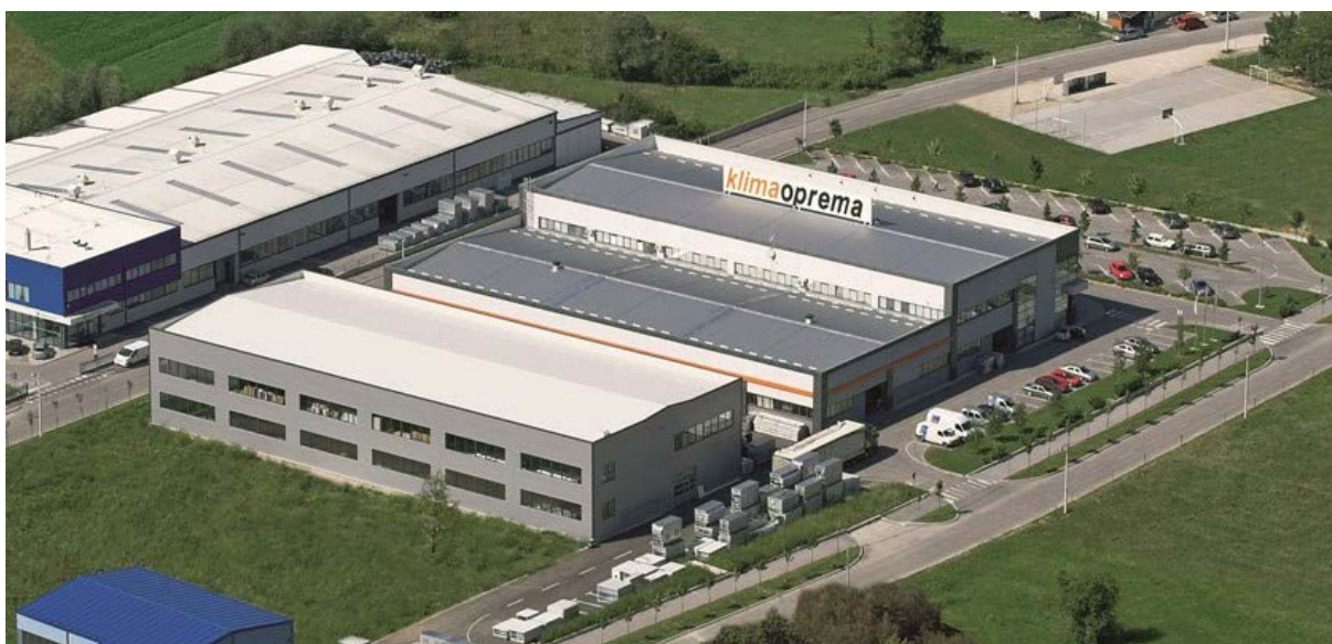
Slika 36. Tvrtnka Klimaoprema d.d. - lokacija Samobor
