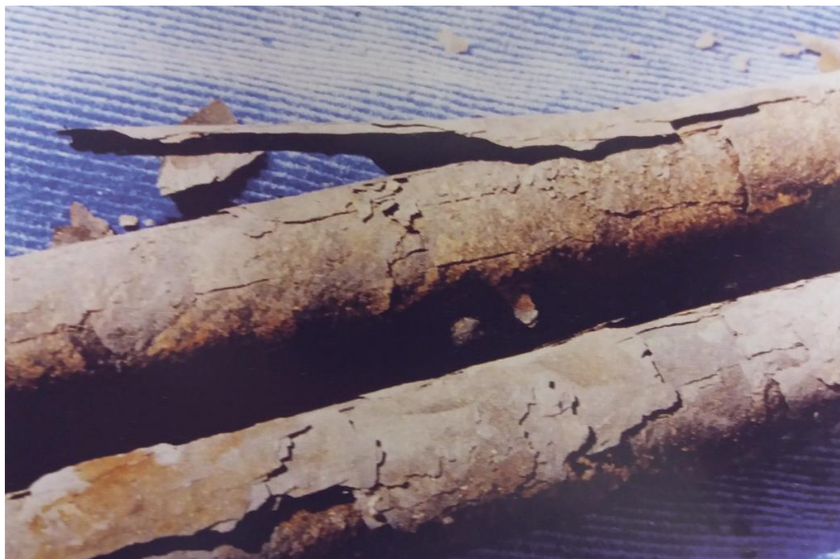
Slika 17. Selektivna korozija 70/30 Cu – Ni legure [21]
