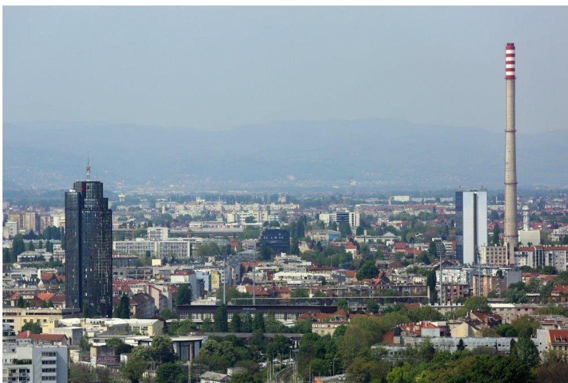
Slika 1.4 Kogeneracijsko postrojenje EL-TO u Zagrebu, primjer daljinskog grijanja
