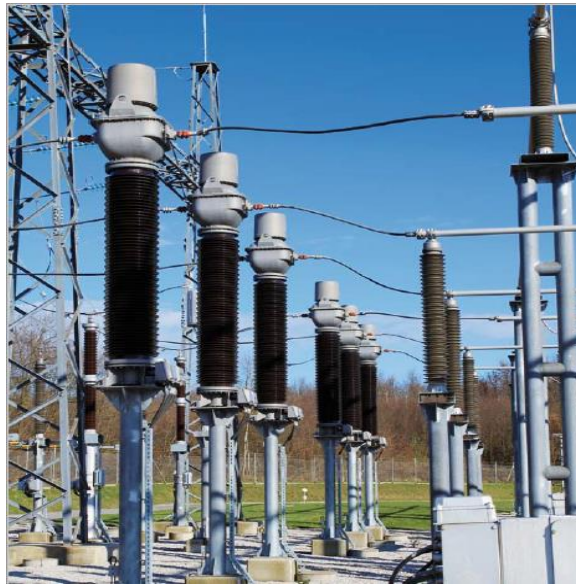
Slika 1. Kombinirani mjerni transformator VAU[1]
