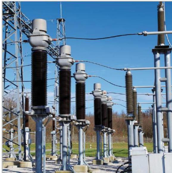
**Slika 1. Kombinirani mjerni transformator VAU[1]**
