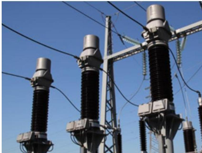
Slika 7. Kombinirani mjerni transformator VAU[1]
