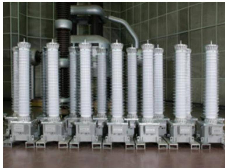
**Slika 4. Kapacitivni naponski mjerni transformator VCU[1]**
