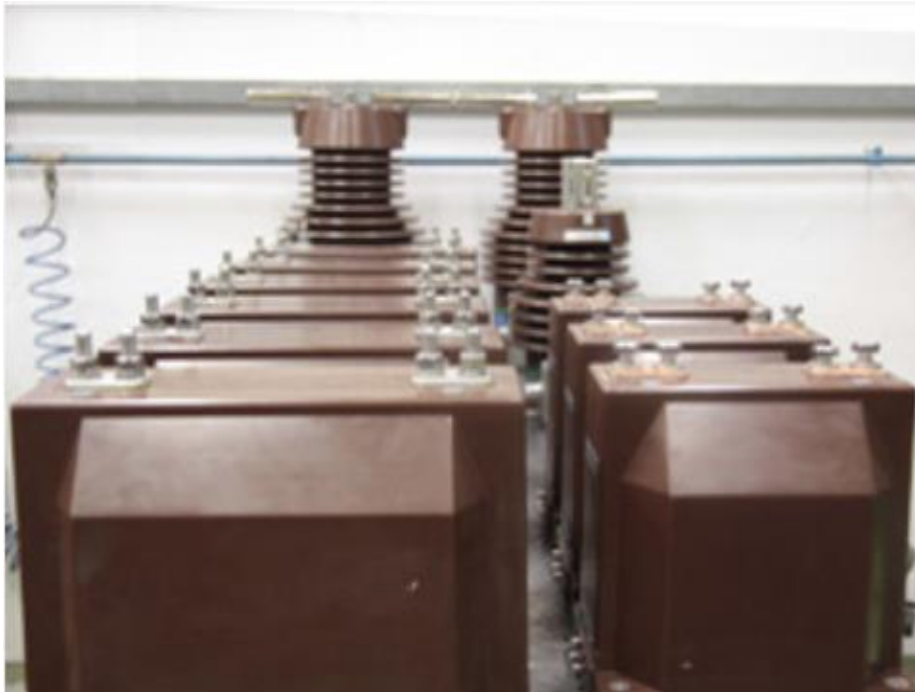
Slika 9. Strujni epoksidni transformator INA[1]
