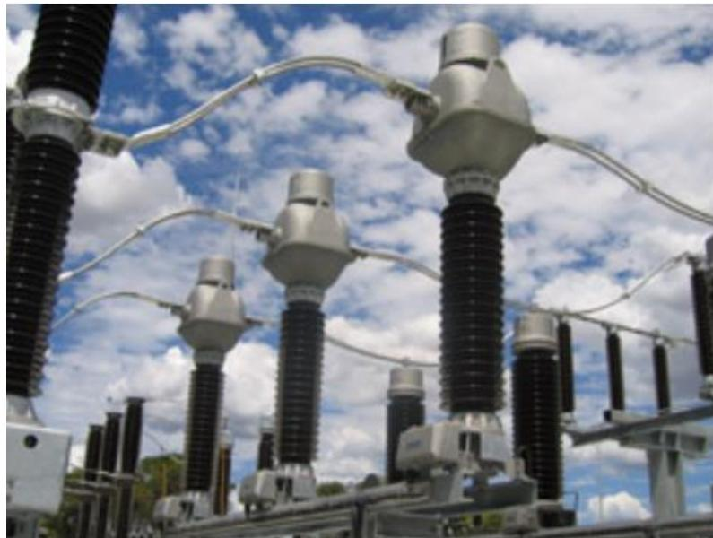
**Slika 3. Strujni mjerni transformator AGU[1]**
