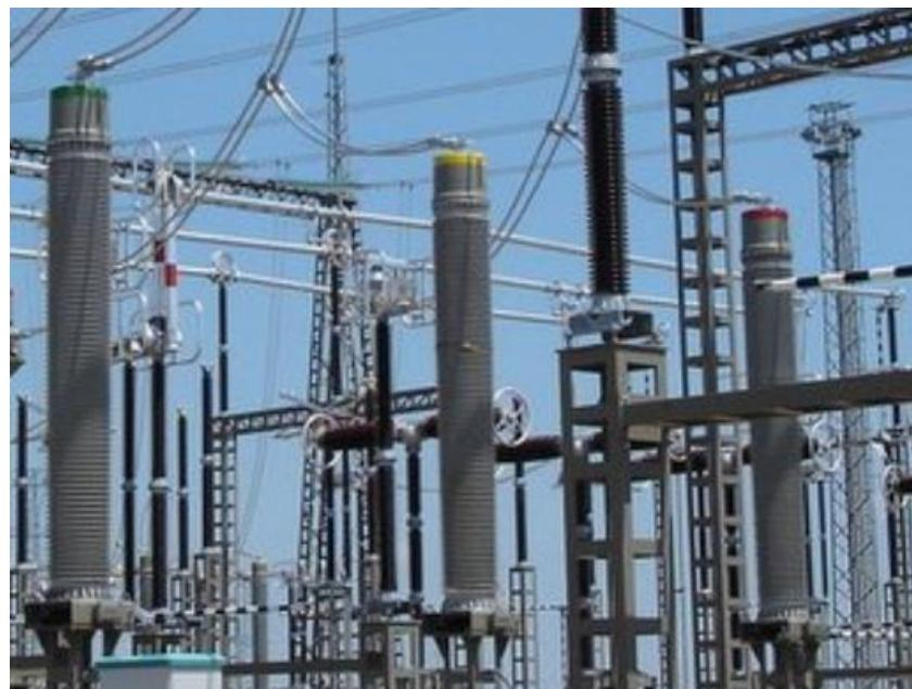
**Slika 6. Induktivni naponski mjerni transformator VPU[1]**
