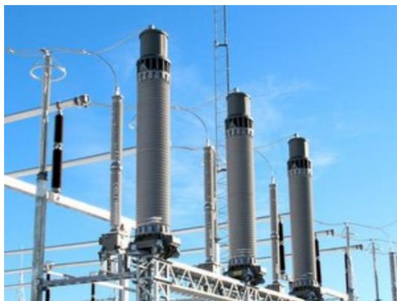
**Slika 5. Naponski mjerni transformator velike snage VPT[1]**
