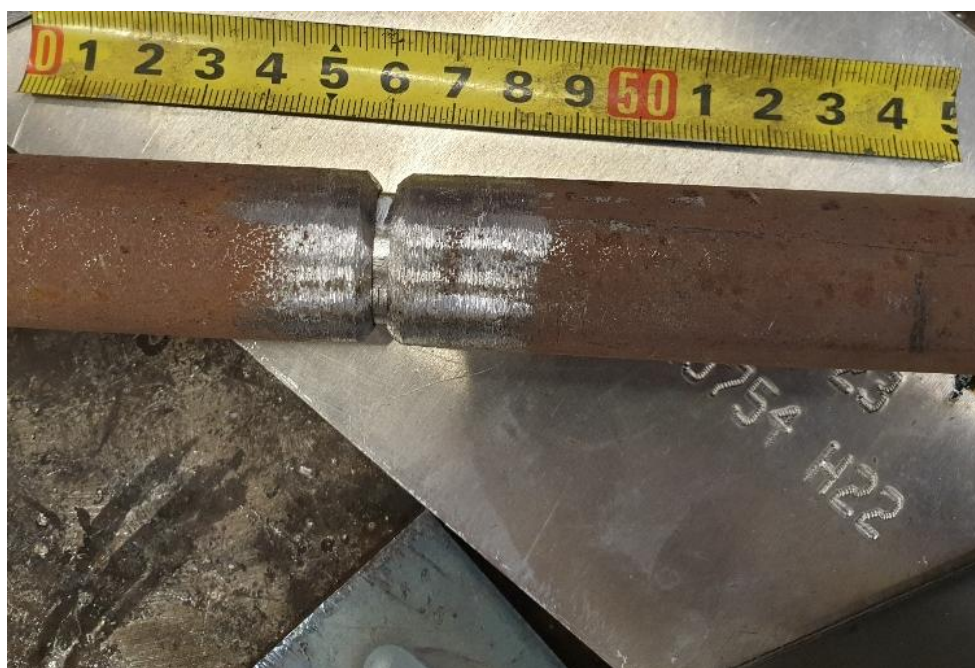
Slika 14. Pripremljene cijevi za zavarivanje čeonog spoja
