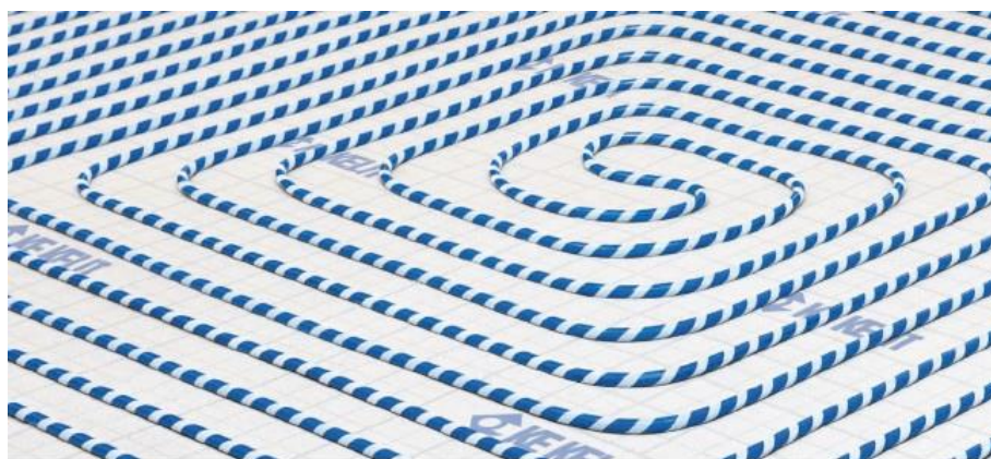
Slika 6. Postavljanje cijevi obložene čičak trakom
