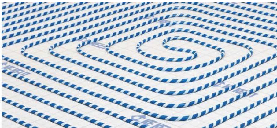
Slika 6. Postavljanje cijevi obložene čičak trakom
