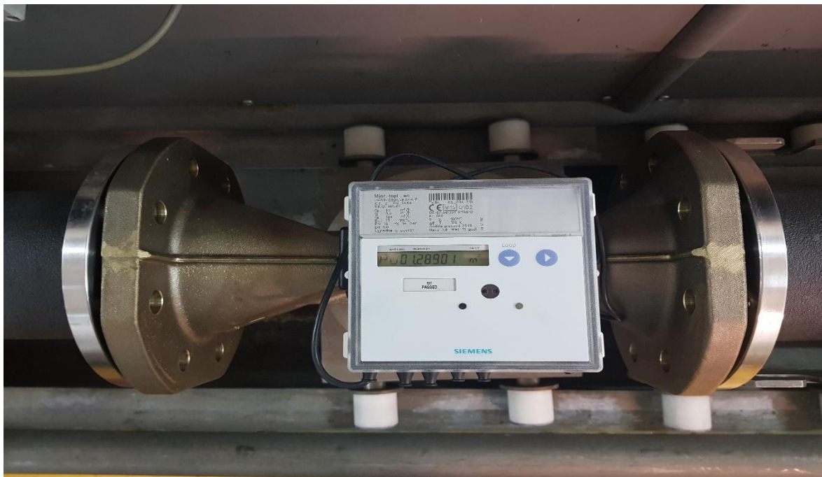
Slika 1. Primjer mjerila toplinske energije
