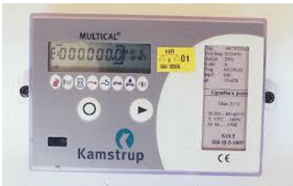
Slika 8 Računska jedinica
