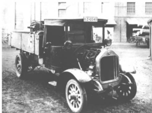
Slika 3. Prvi automobil pogonjen Diesellovim motorom s izravnim ubrizgavanjem goriva [2]
