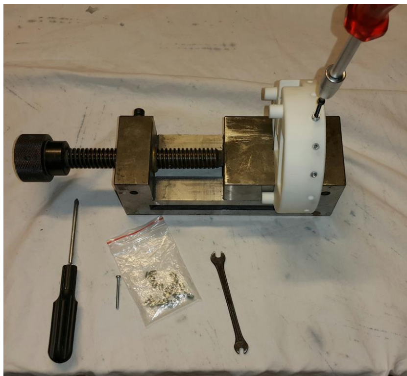
Slika 40. Ugrađivanje metalnih navojnih uložaka
