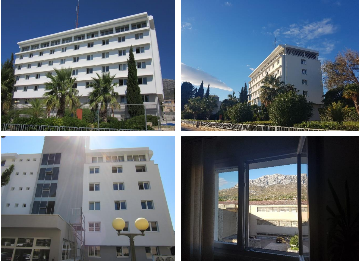
Slika 3.2 Postojeće stanje zgrade gradske uprave Grada Kaštela (prosinac, 2018.)
