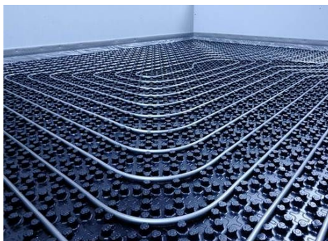
Slika 10. Podno grijanje s čepovima [4]
