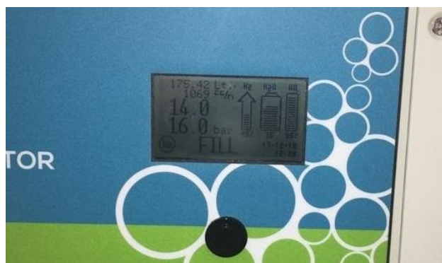
Slika 58. Zaslonelektrolizatora u radu
