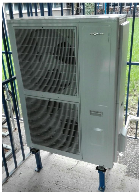
Slika 2. Vanjska jedinica dizalice topline
