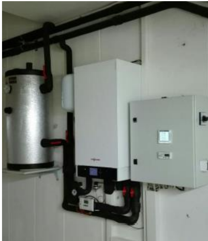
Slika 3. Unutarnja jedinica dizalice topline
