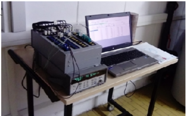
Akvizijski sustav: Temperatura Tlak Snaga kompresora Toplinski učin COP
