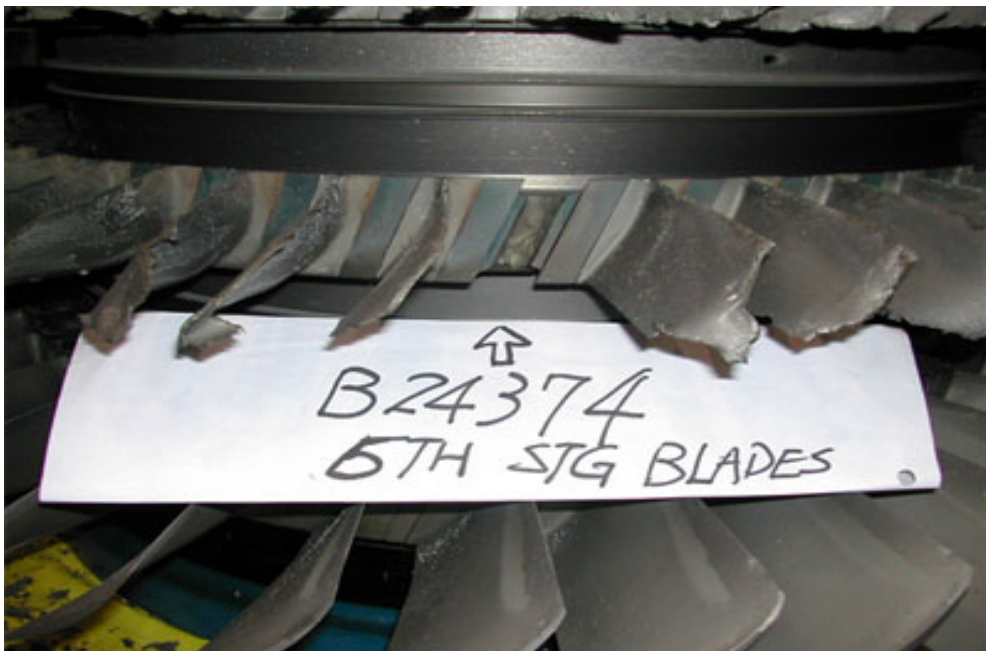
Slika 9. Erozija krutim česticama na rotoru turbine [2]
