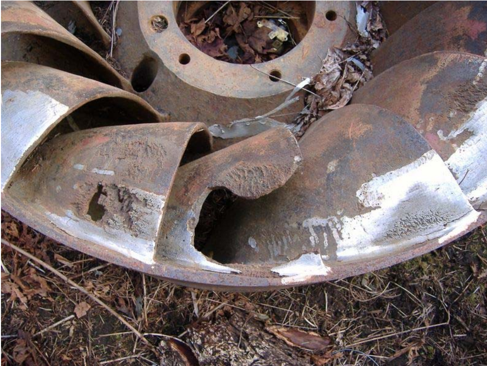
Slika 8. Erozijska krutim česticama na rotoru turbine [2]
