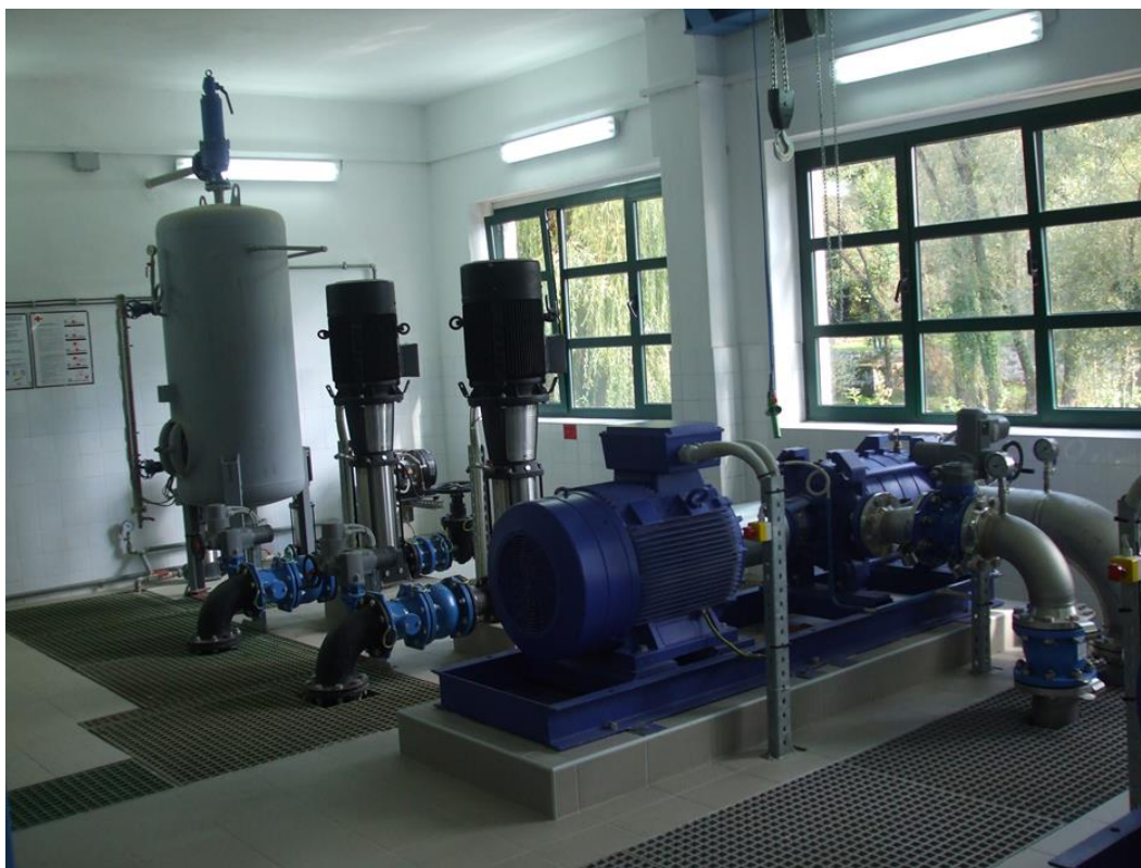
Slika 10. Sustav za kemijsku dezinfekciju vode, izvor rijeke Rude [7]
