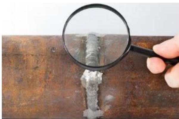
Slika 5.1. Vizualna kontrola zavara [35]
