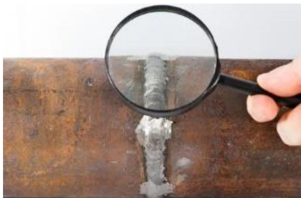
Slika 5.1. Vizualna kontrola zavara [35]
