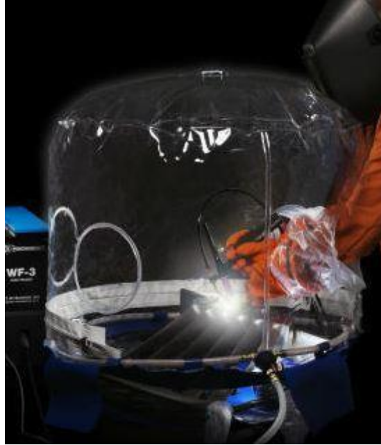
Slika 22: Izvođenje postupka zavarivanja u komori za zavarivanje [29]
