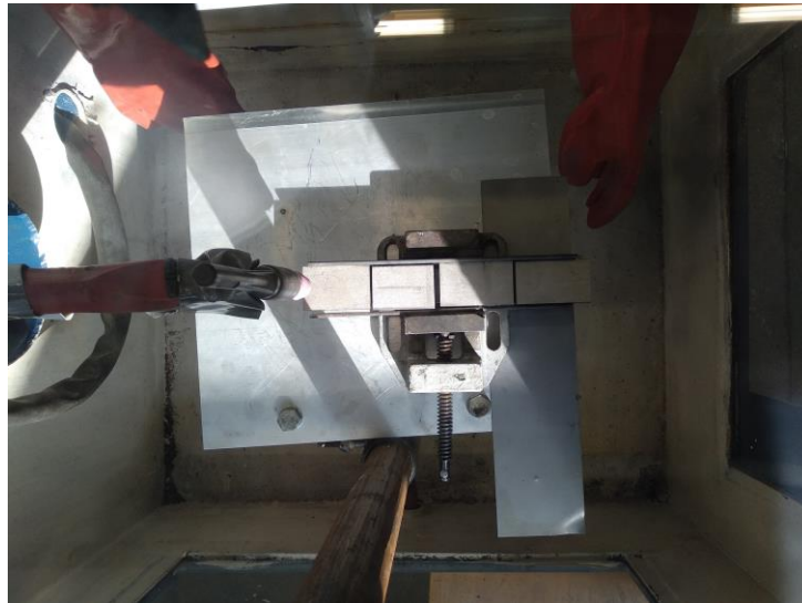
Slika 29: Izgled unutrašnjosti komore prije izvođenja jedne od faza navarivanja
