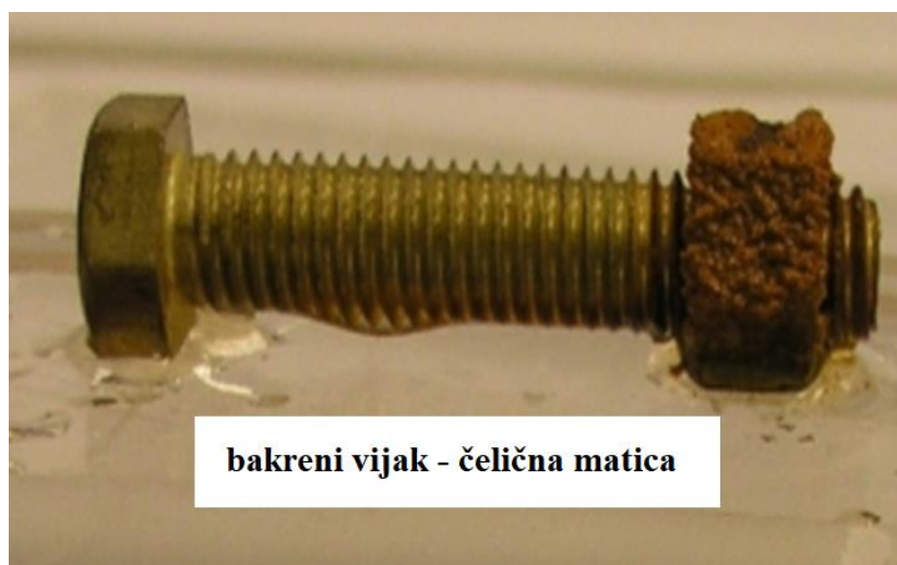
Slika 26. Galvanska korozija između bakrenog vijka i čelične matice [27]
