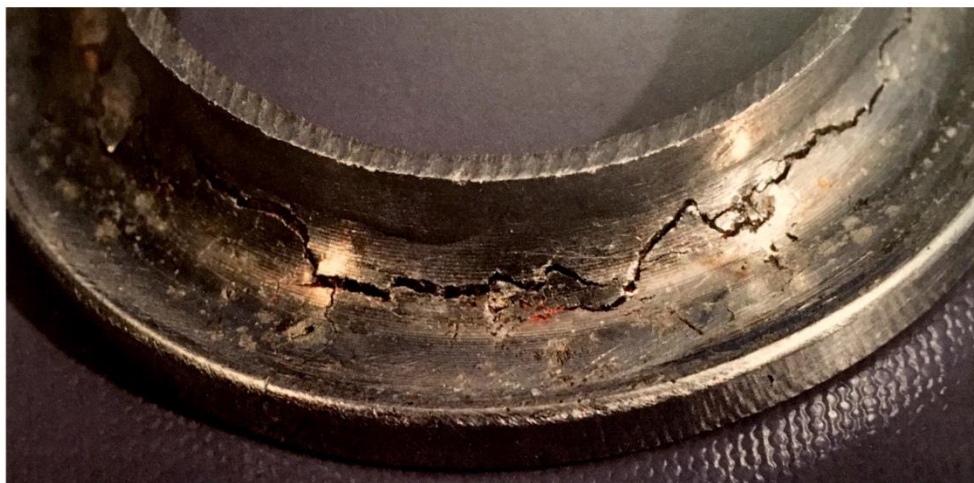
Slika 11. Prikaz napetosne korozije na izmjenjivaču topline korištenom u prehrambenoj industriji [1].
