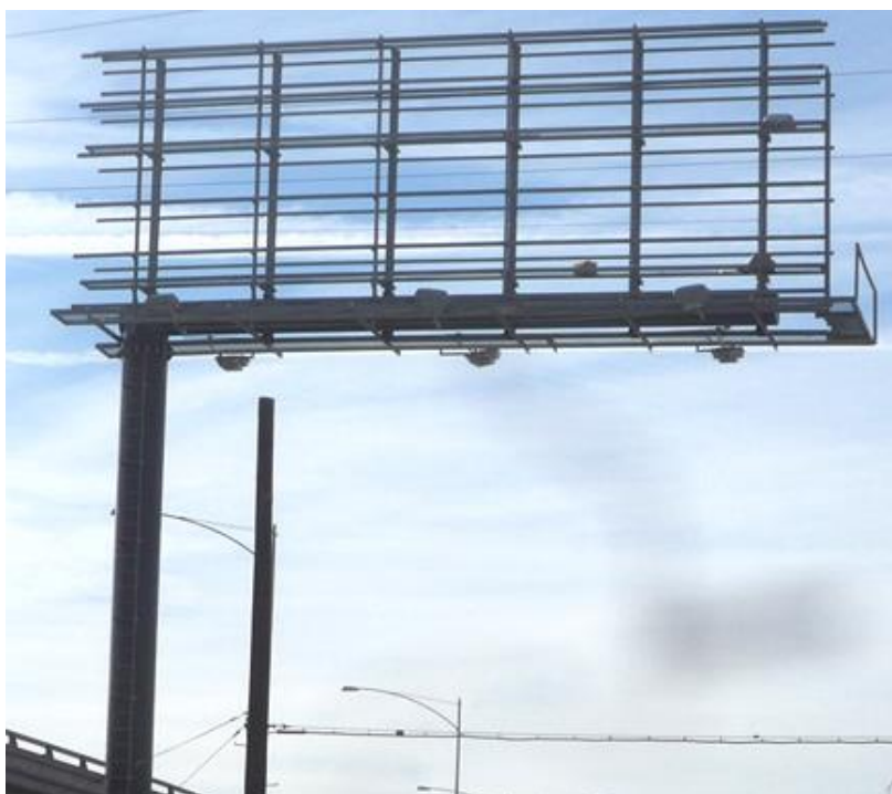
Slika 2. Standardna nosiva konstrukcija billboard panoa [5]
