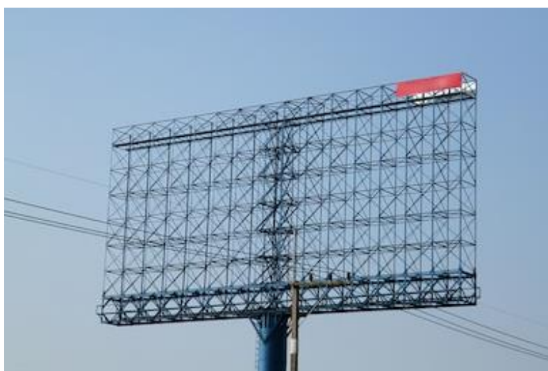
Slika 3. Rešetkasta nosiva konstrukcija bez torzijske cijevi [6]
