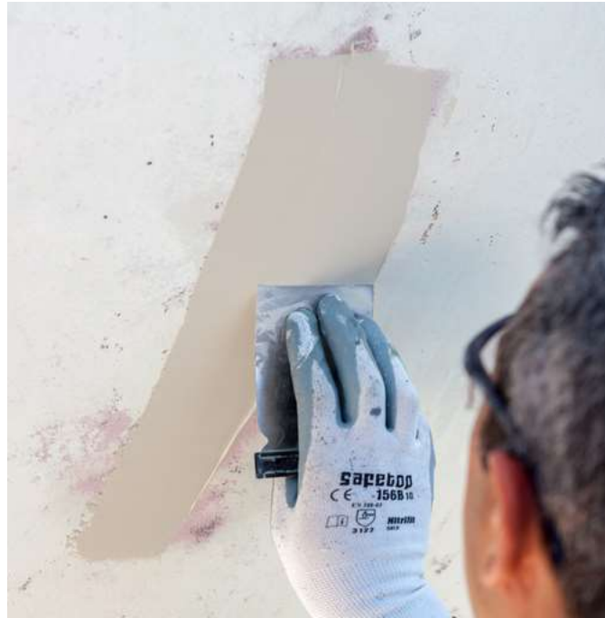
Slika 28. Poravnavanje površine kitom [19]
