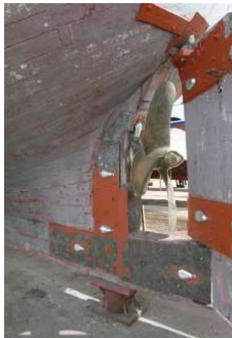
Slika 16. Katodna zaštita metalnih dijelova na drvenom brodu [5]
