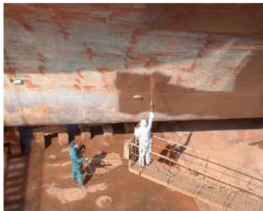
Slika 18. Nanošenje temeljnog premaza na vanjsku oplatu broda [15]
