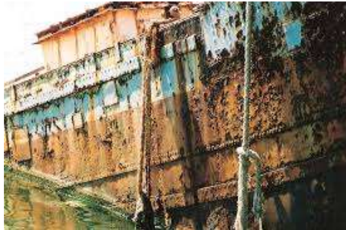
Slika 5. Opća korozija vanjske oplata broda [6]
