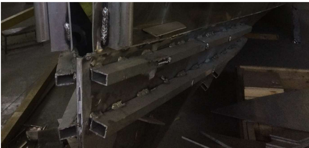
Slika 27. Kvadratni profili zavareni za vanjsku oplatu
