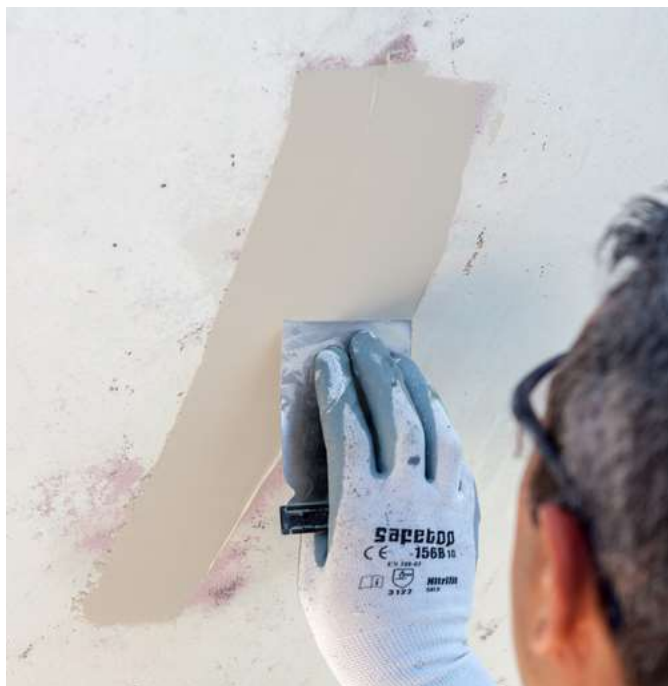
Slika 28. Poravnavanje površine kitom [19]
