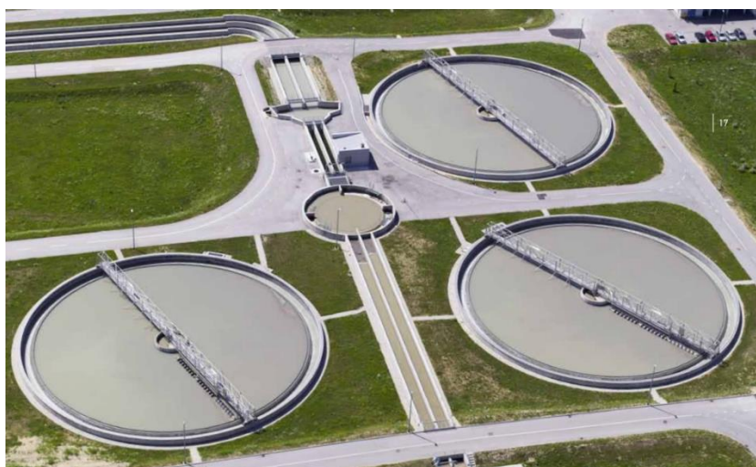
Slika 3. Kružni taložnici Centralnog uređaja za pročišćivanje otpadnih voda Zagreb [6]
