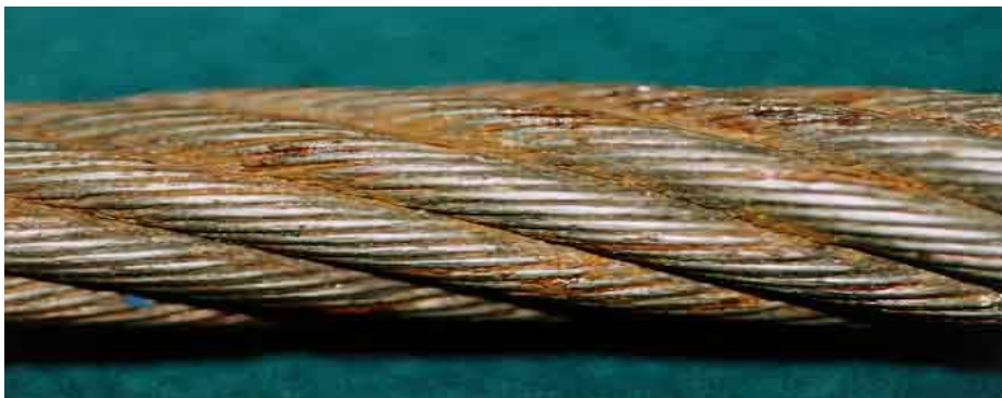
Slika 5. Korozijski oštećeno čelično uže [5]
