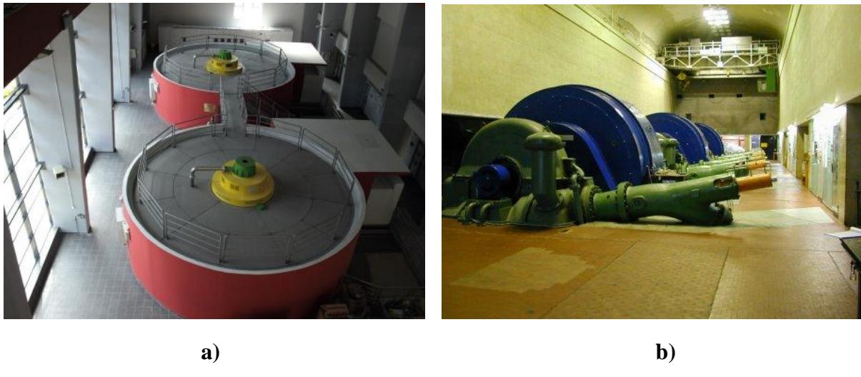
**Slika 1.** Hidrogeneratori: a) vertikalni, HE Lešće; i b) horizontalni, HE Vinodol [2]
